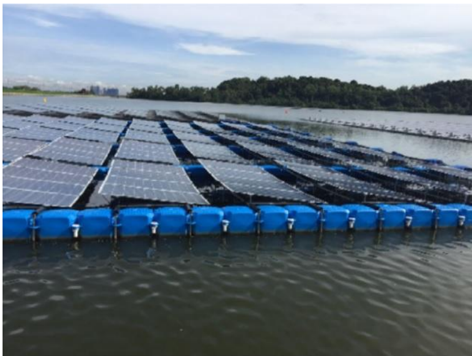
شکل ۵. نمایی از نصب پنل خورشیدی شناور
