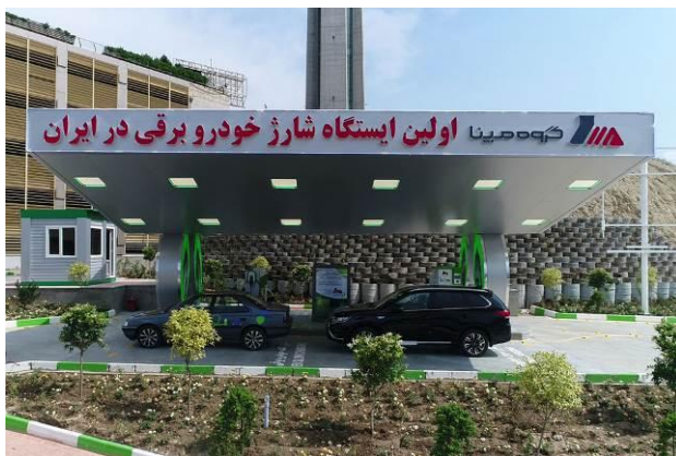
شکل (۱): ایستگاه های شارژ خودروی برقی گروه مپنا
